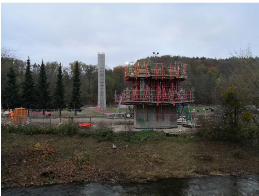
Obr. 21 Pohled na posuvné bednění P40 a dokončený pilíř P30
