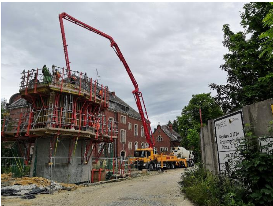
Obr. 15 Betonáž taktu 2 pilíře P50
