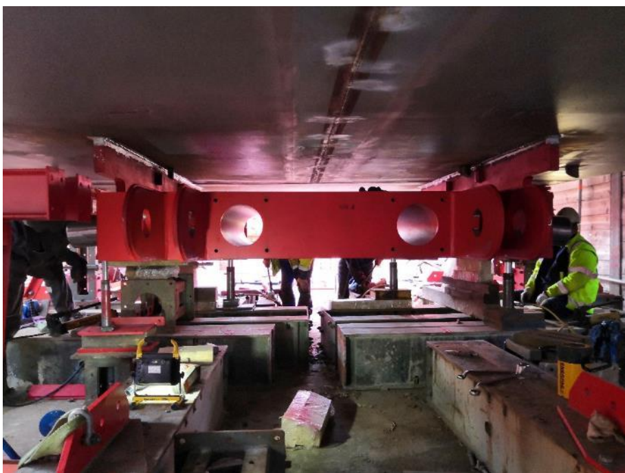
Obr. 25 Osazování výsuvného prvku (zde se budou kotvit výsuvná lana)
