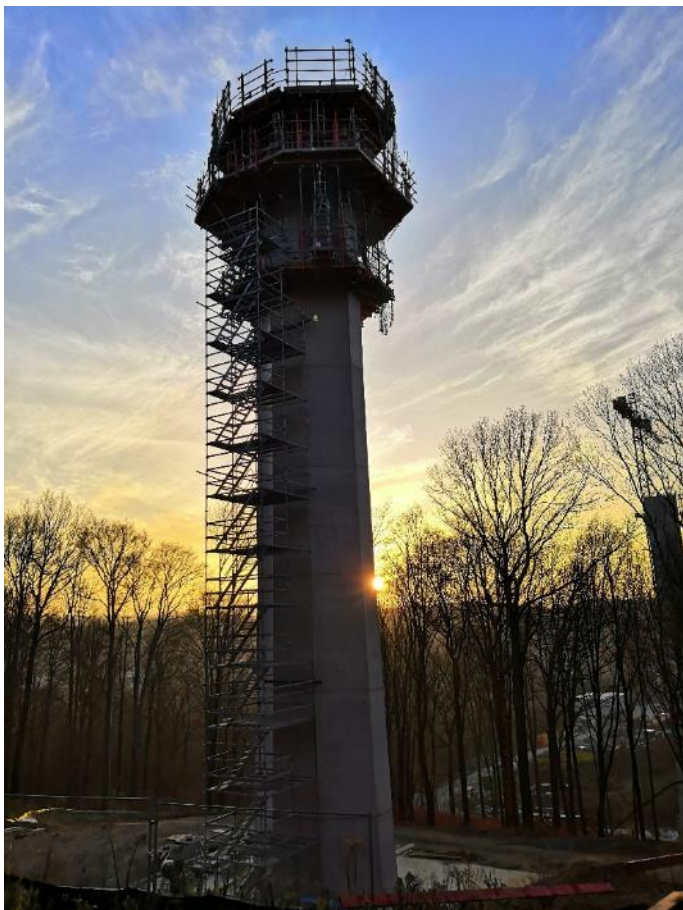
Obr. 22 Příprava bednění taktu 9 P80
