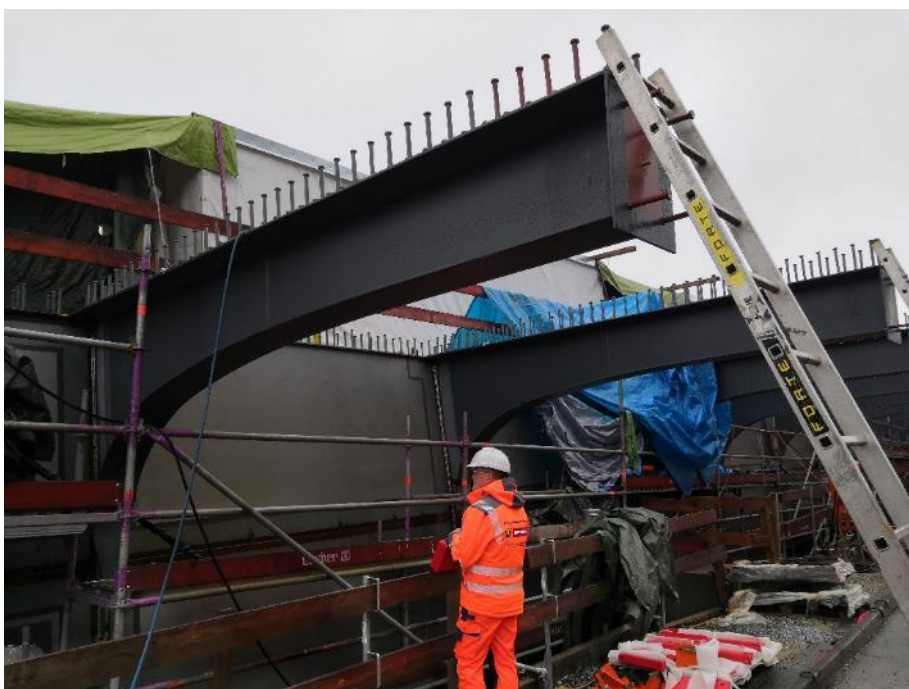
Obr. 19 Montáž konzol ocelové konstrukce ve výsuvném dvoře
