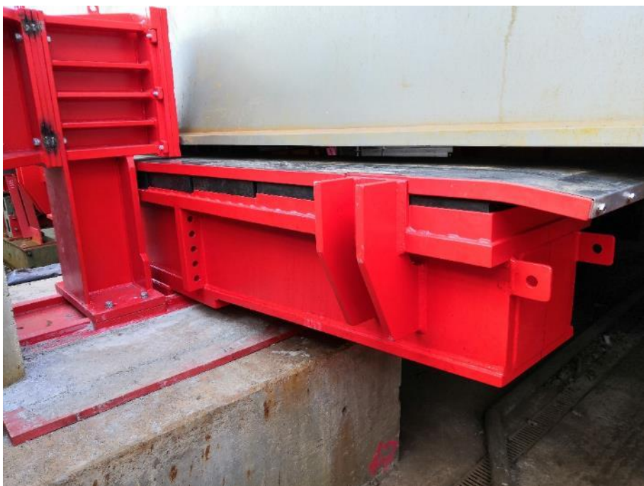
Obr. 26 Detail výsuvného ložiska ve výsuvném dvoře
