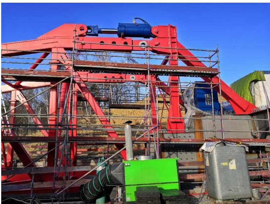
Obr. 27 Detail hydrauliky výsuvného nosu
