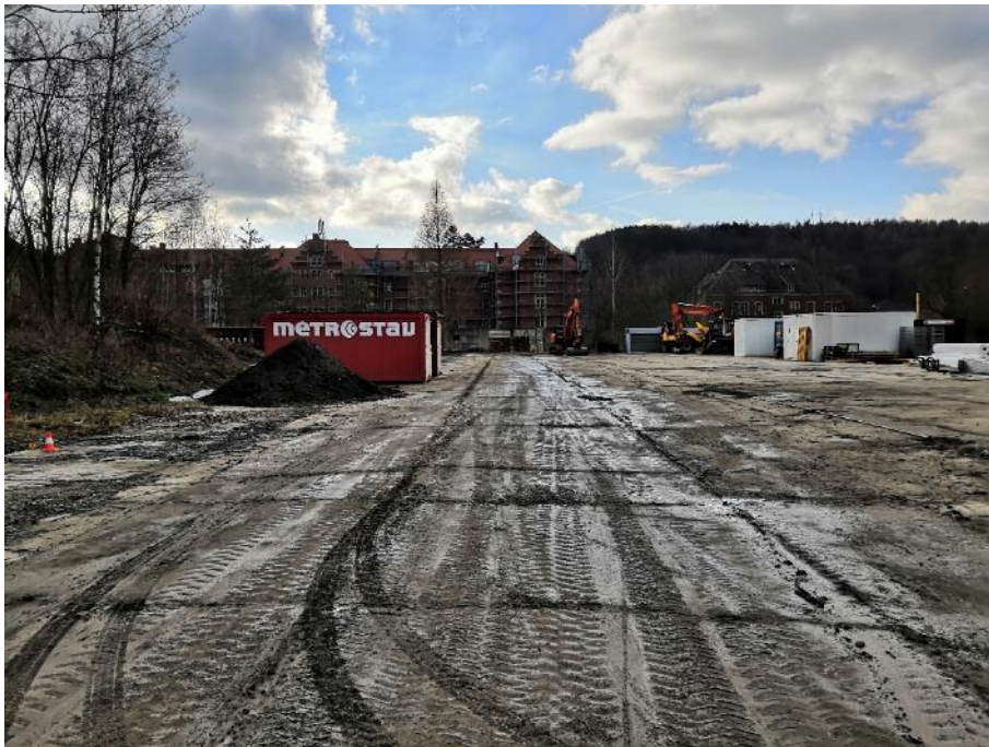
Obr. 6 Příprava zařízení staveniště 01/2019
