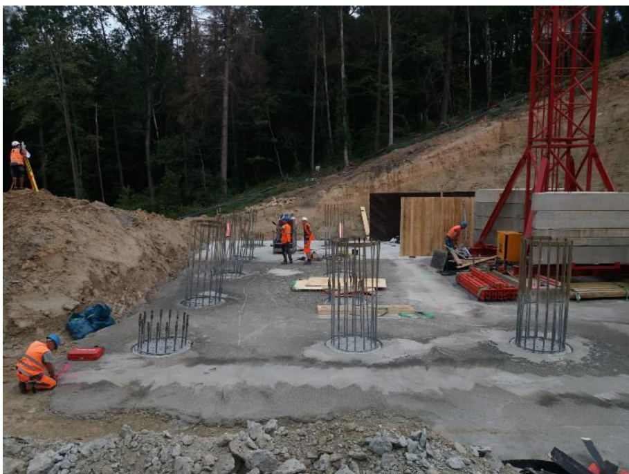
Obr. 10 Podkladní beton WL100, věžový jeřáb
