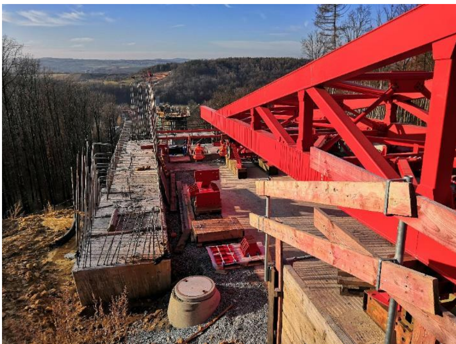
Obr. 24 Osazený výsuvný nos ve výsuvněn dvoře směrem na WL100
