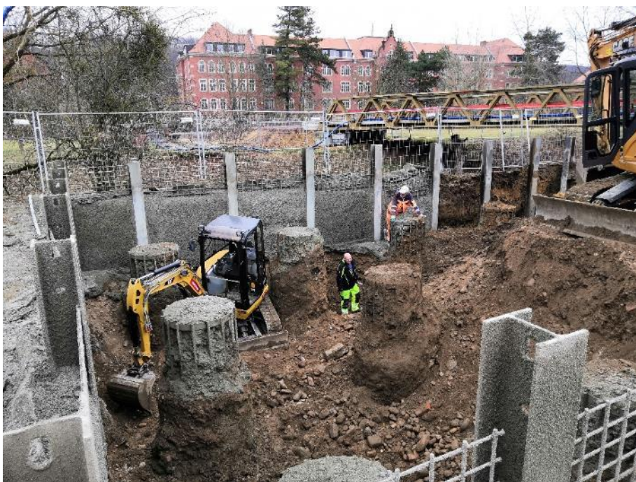
Obr. 13 Pažená jámka pilíře P40
