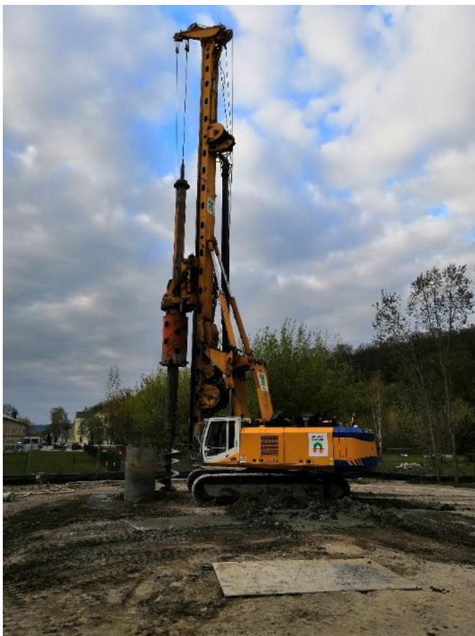
Obr. 7 Zhotovení velkopřůměrových pilot P60
