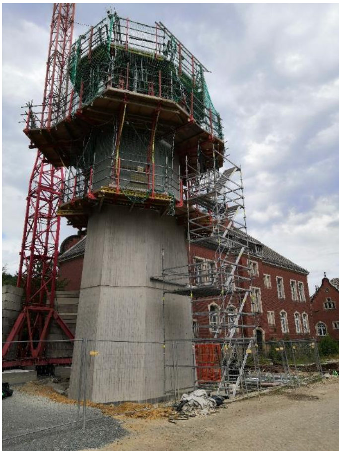
Obr. 16 Překládání bednění pro takt 5 P50
