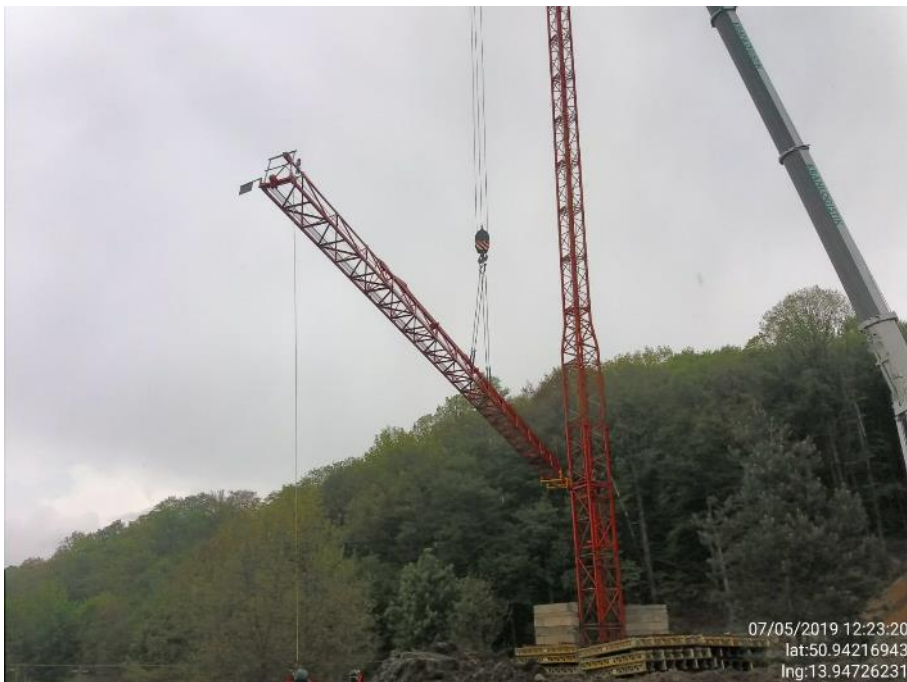
Obr. 8 Montáž věžového jeřábu P70
