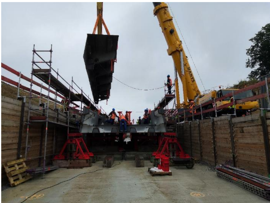
Obr. 17 Osazování ocelové konstrukce do výsuvného dvora
