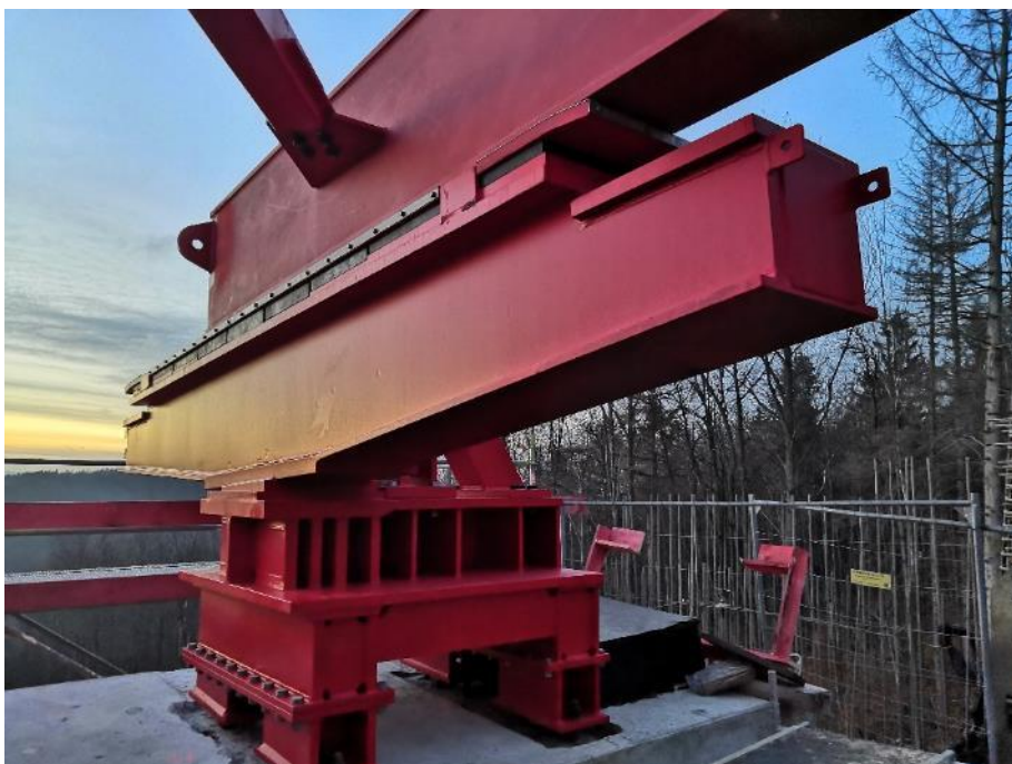
Obr. 28 Detail výsuvného ložiska na WL100
