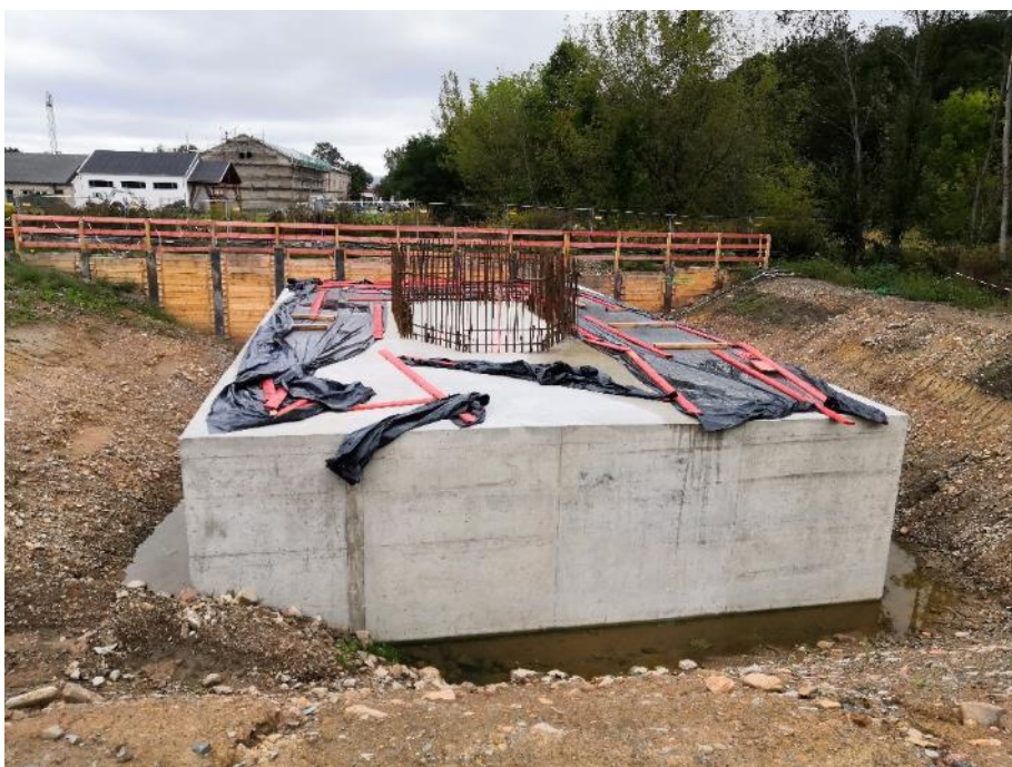
Obr. 11 Zhotovený základ P60, 550m 3
