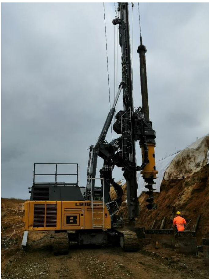
Obr. 14 Zhotovení záporového pažení výsuvného dvora
