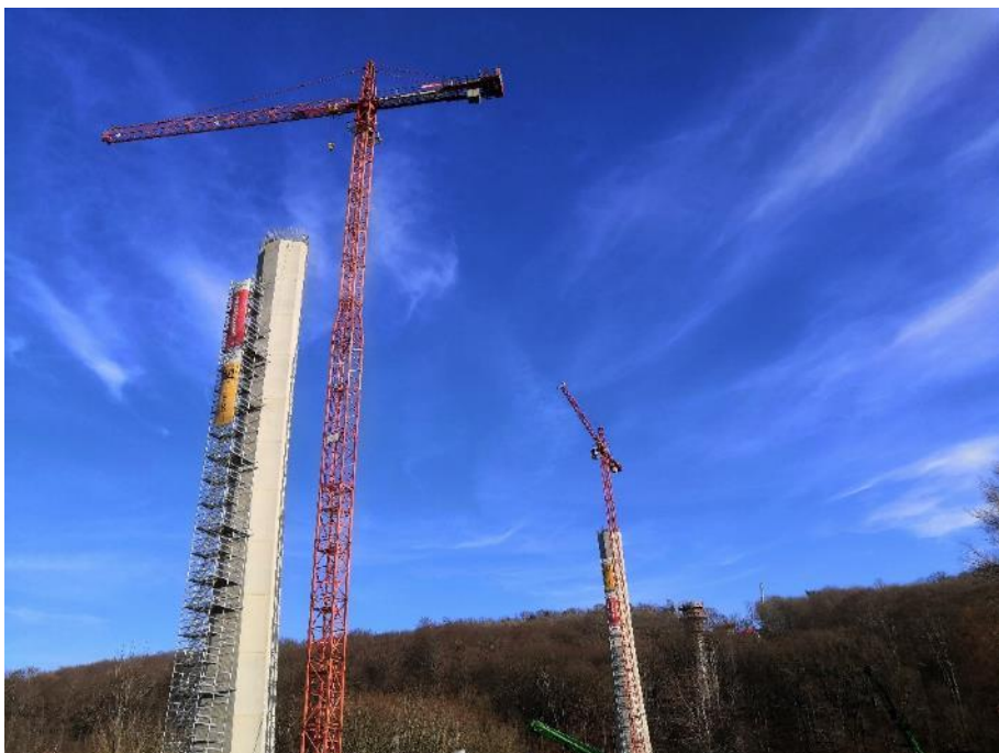
Obr. 23 Dokončené P60 a P70
