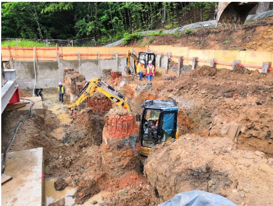
Obr. 9 Odtěžení základu P70, hluché vrtání
